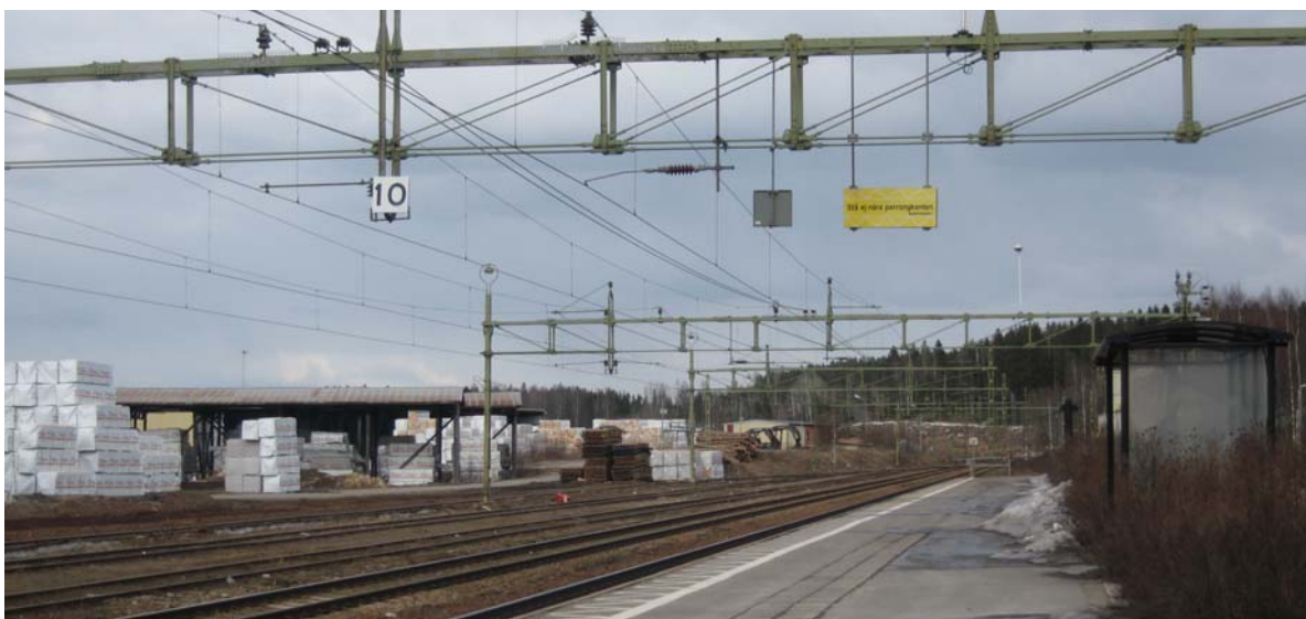
Godsstråket genom Bergslagen, vid Skinnskattebergs station.
