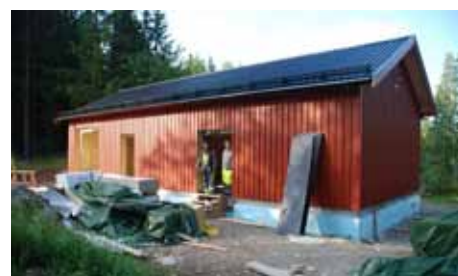
En ny byggarbetsdag vid vattenverket i Färna
