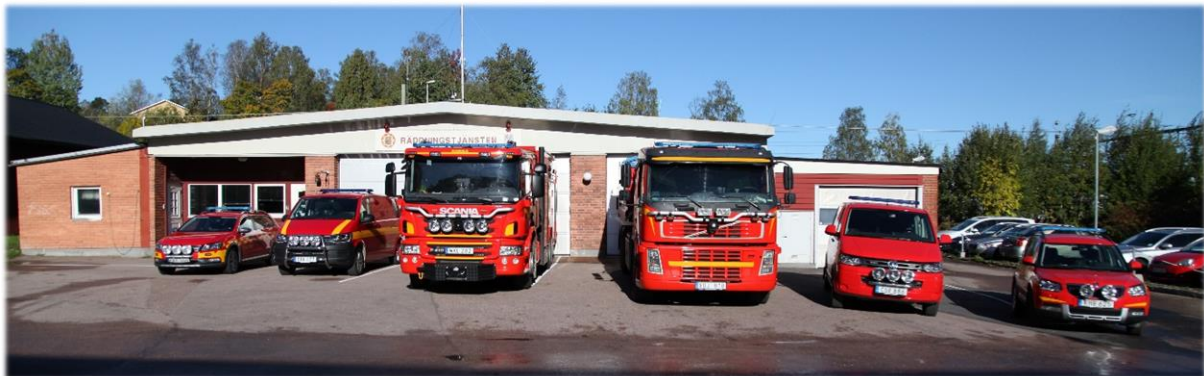
Bild 8.1 Skinnskattebergs räddningsstation med räddningsfordon
