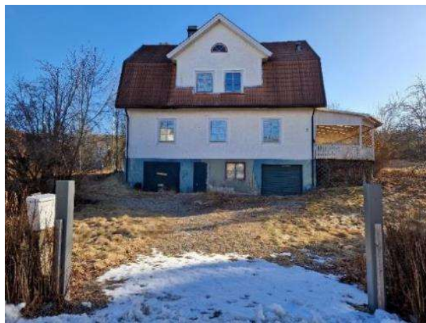
Figur 9 Fasad och källare mot väster och Centralvägen.
