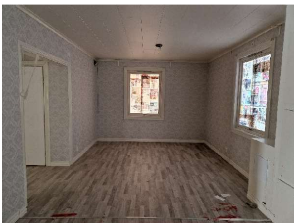
Figur 22 Del av rum 103 som tidigare varit två rum.
