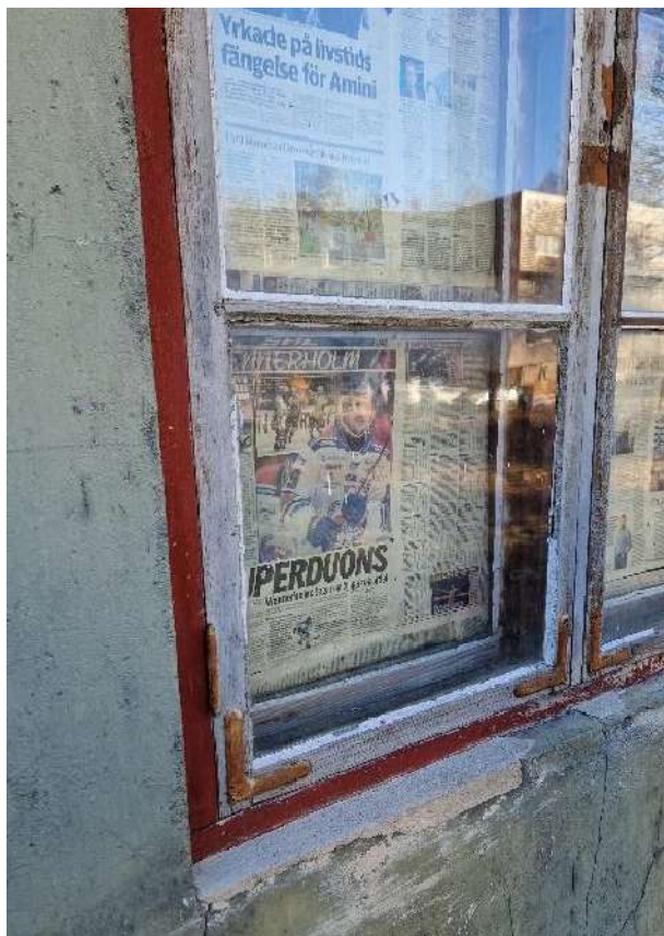
Figur 11 Fönster med rester efter ockragul linoljekulör vid källarentré.
