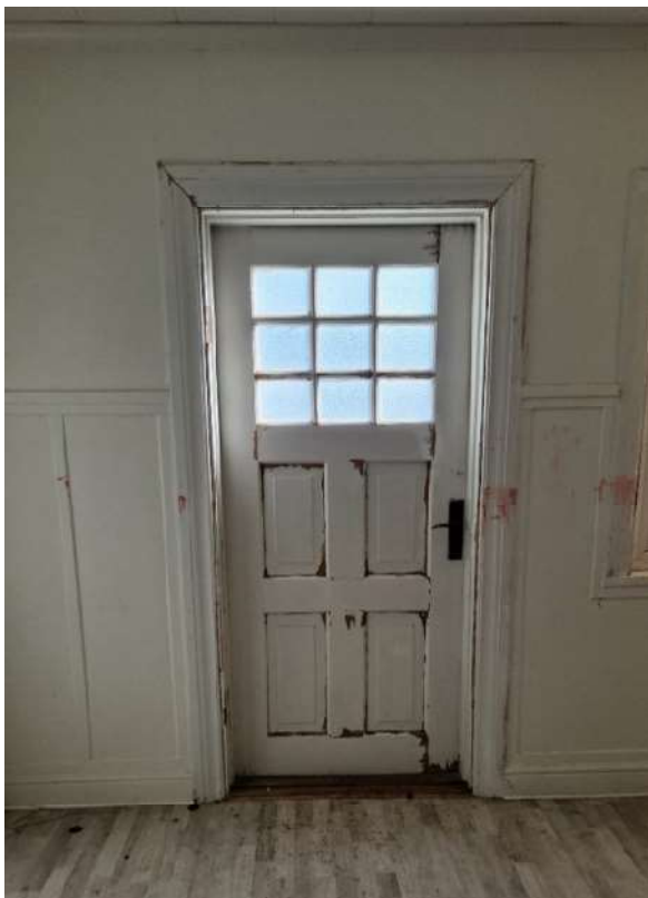
Figur 30 Balkongdörr i hallen – rum 201.
