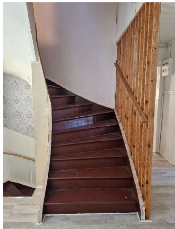
Figur 29 Trappa med ledare upp till vind.
