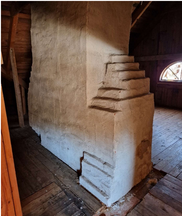
Figur 46 Murstocken på vinden.
