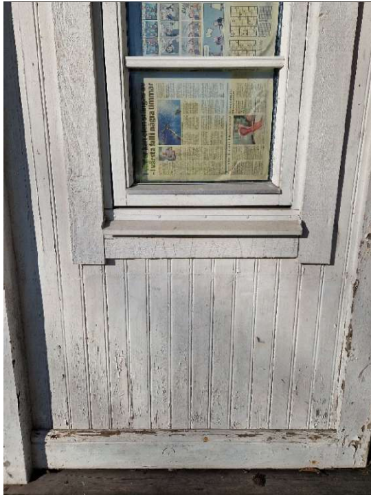
Figur 15 Fasaden kring dörren är klädd med smal pärlspont.
