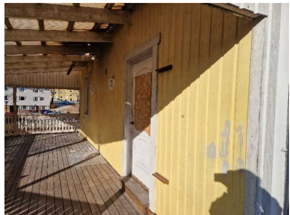
Figur 18 Köksentrén leder ut till ett altandäck under skärmtak som byggdes 1996.
