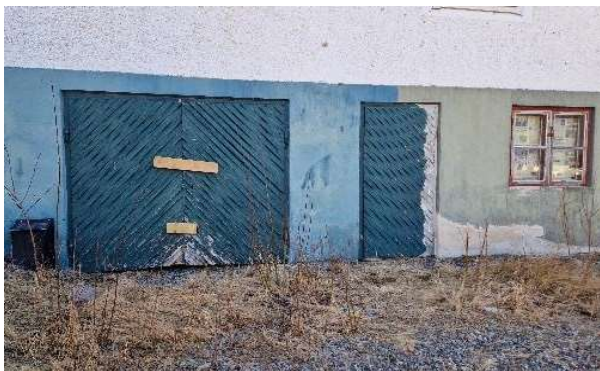
Figur 10 Källarentré och garageport.
