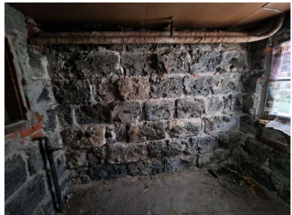
Figur 38 Rum 004 i källaren med fönster och källardörr åt Centralvägen.
