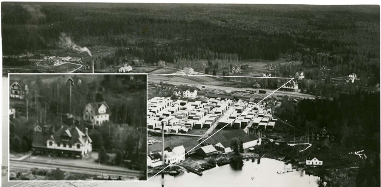
Figur 4 Flygbild från 1932 över boardfabriken med stationshuset och bostadshuset i bakgrunden. På norra gaveln syns trappan in till butikslokalen. Grunden var målad ljus lite övriga fasader. Bildkälla: Västmanlands läns museum, Vlm-E-5799.
