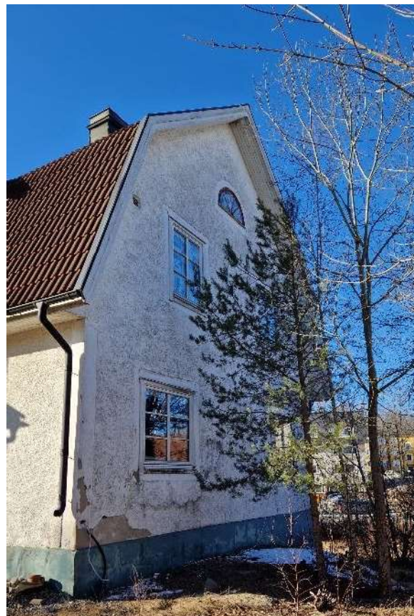
Figur 13 Fasad mot norr.
