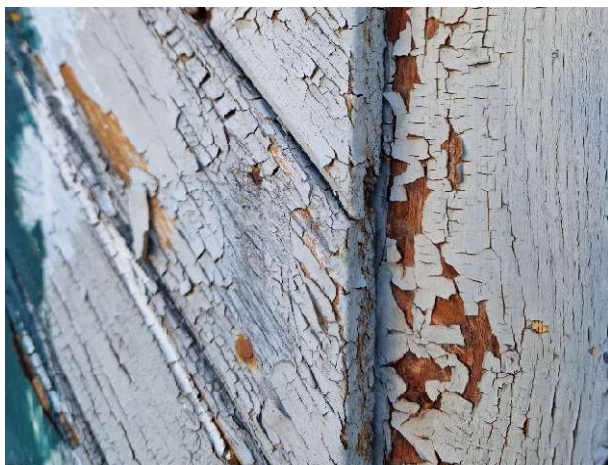
Figur 12 Dörr med färgrester av röd och ockragul linoljefärg
