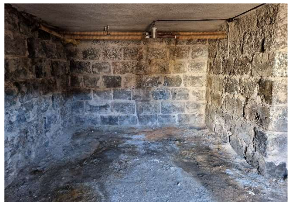
Figur 39 Norra garageutrymmet – rum 003 - med synlig slaggstensstomme.
