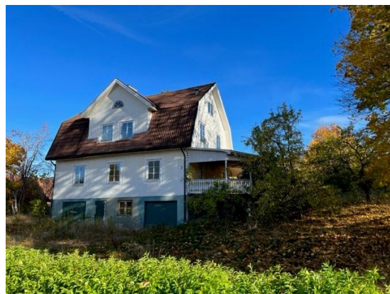
Figur 18. Befintligt bostadshus på fastigheten Prästgården 1:90.
