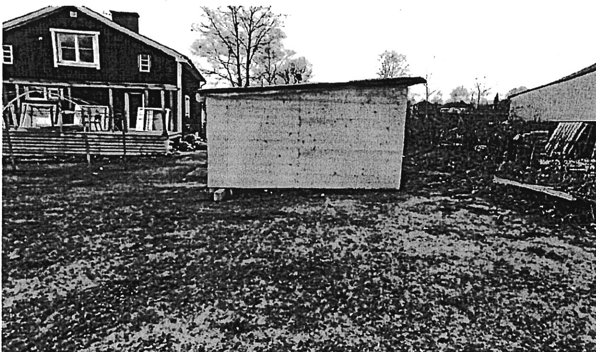
Foto från tillsynsbesök, 2024-11-20, fasad mot öster.
