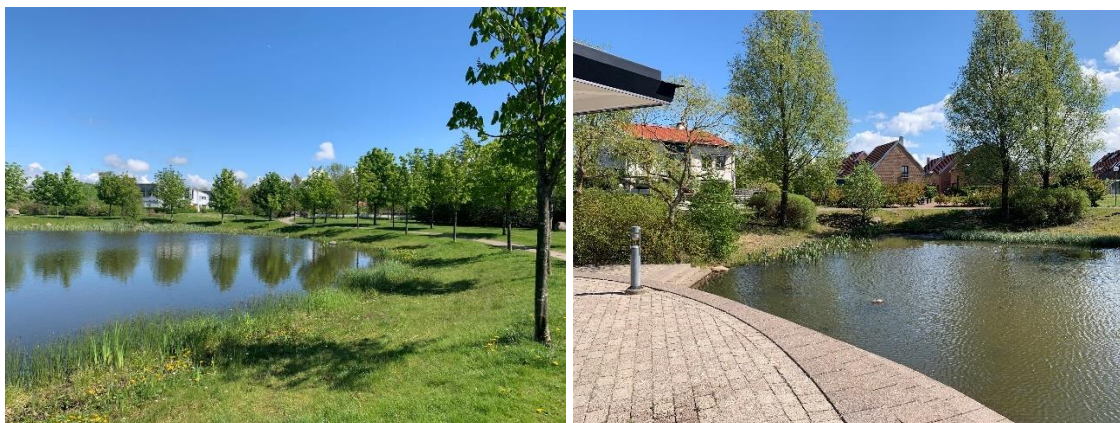
Figur 18. Exempel på dagvattendammar (Foto: Bjerking)
