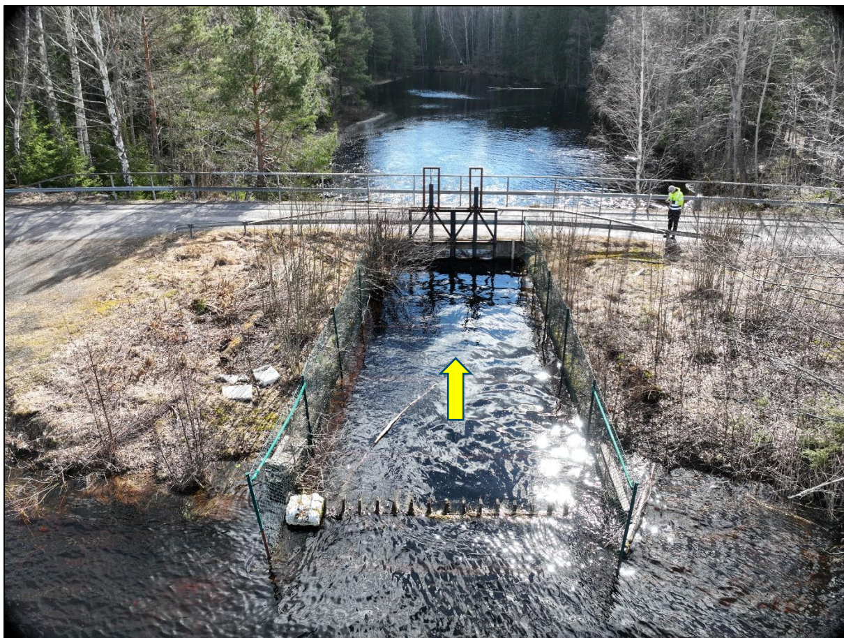
Figur 3.2. Liens regleringsdamm sedd från uppströmssidan. I bilden syns intagsgallret i trä och de båda spetluckorna.
