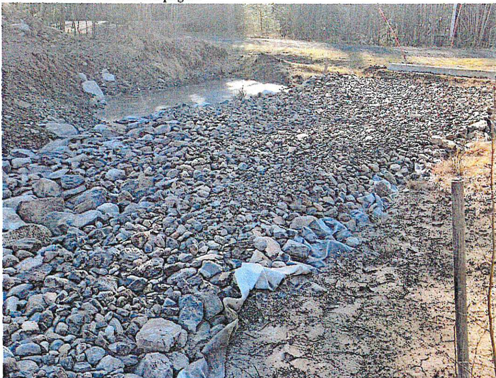
Diverse markarbeten som pågår.
