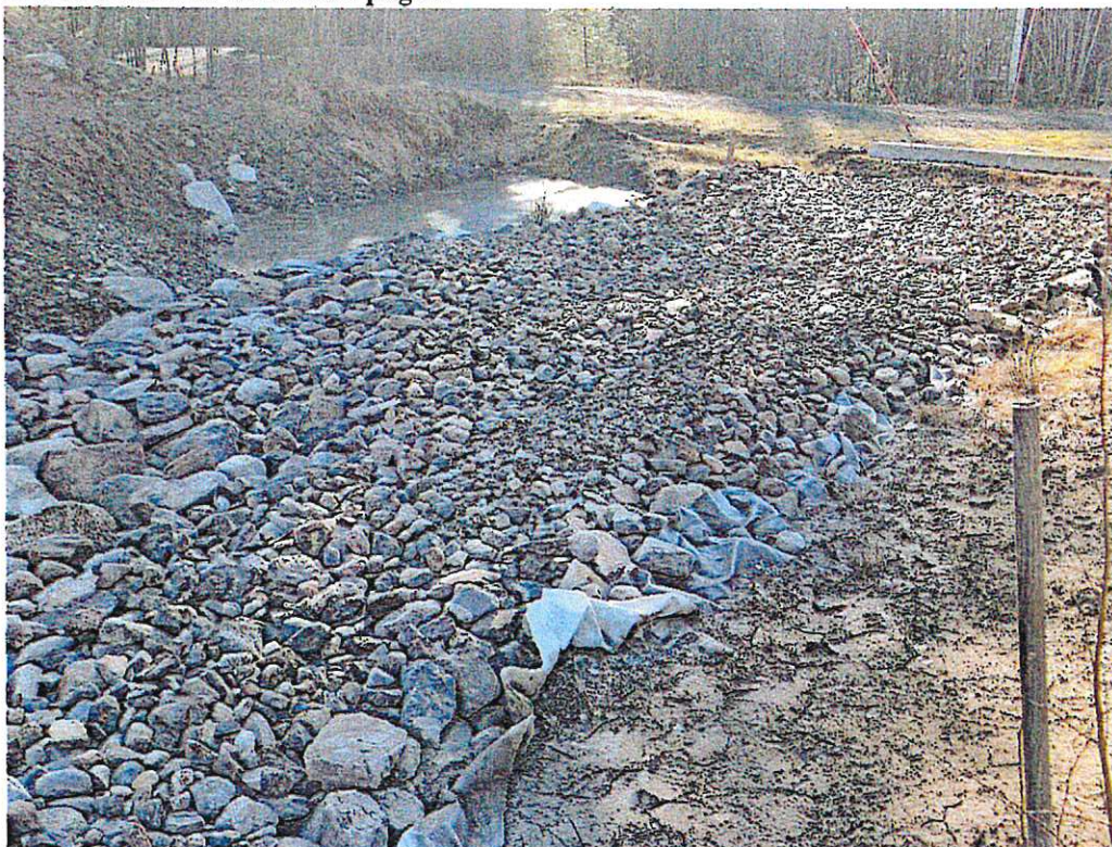
Diverse markarbeten som pågår.
